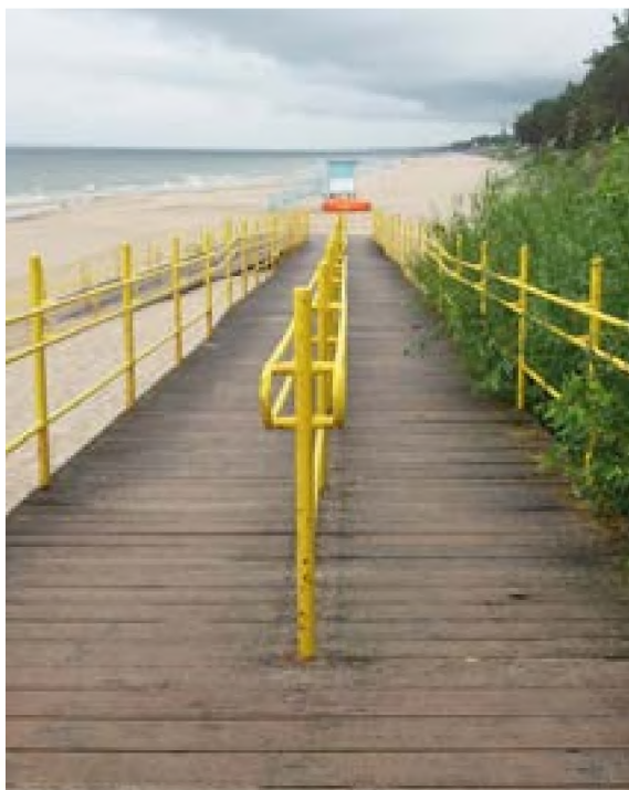
Pochylnia o łagodnym kącie nachylenia i z obustronnymi poręczami, brak krawężników
