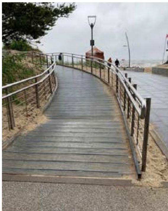
Dość szeroka pochylnia, z obustronnymi poręczami na dwóch wysokościach i krawężnikami
