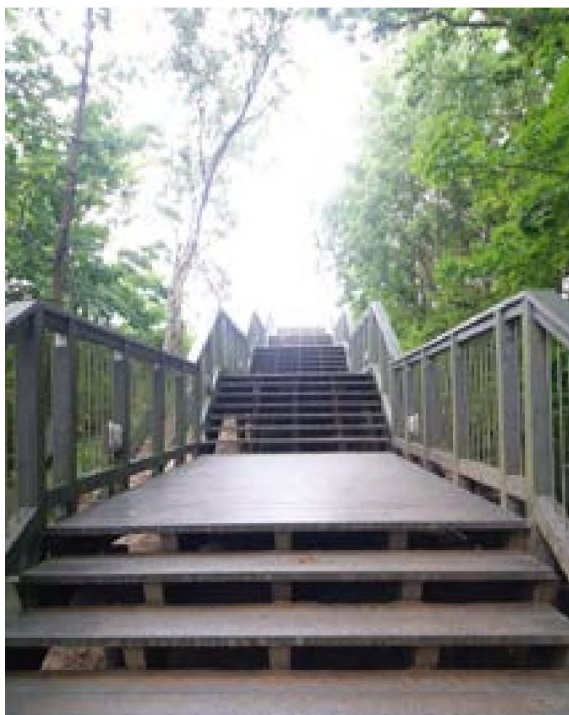
Ażurowe schody bez oznaczeń kontrastowych, z obustronnymi, dość niewygodnymi poręczami
