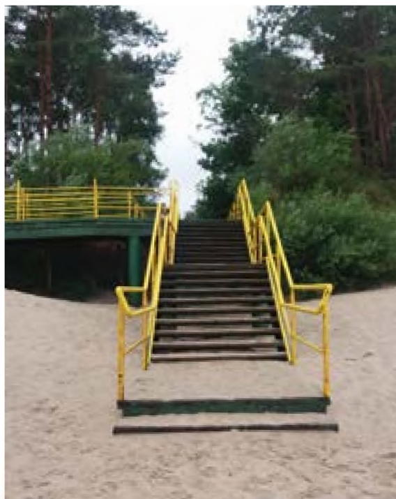
Schody z obustronnymi poręczami, zamontowanymi na dwóch wysokościach, bez oznaczeń kontrastowych, Mielno
