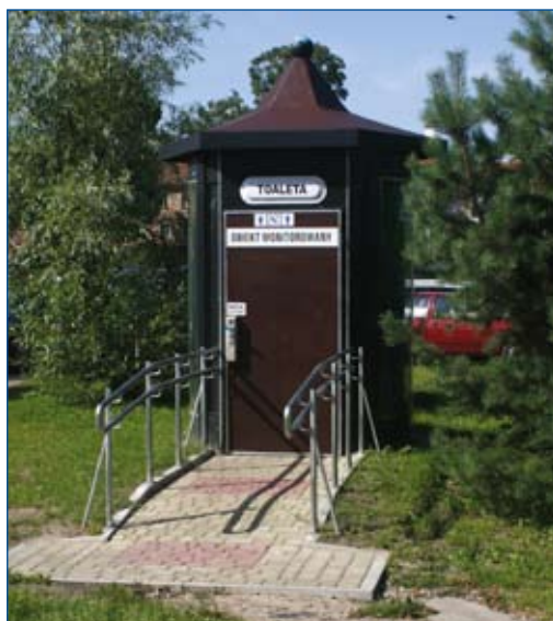
Fot. 12. Toaleta publiczna Mrągowie. W tym przypadku osoby poruszające się na wózkach inwalidzkich mają utrudniony dojazd oraz mogą mieć kłopoty z otwarciem drzwi przez zbyt blisko zamontowane poręcze (zdj. M. Wysocki).
