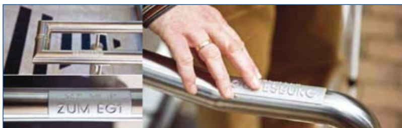
Fot. 10. Dzięki oznaczeniom na poręczach osoba niewidoma może zorientować się, na którym poziomie budynku znajduje się obecnie 42 .
