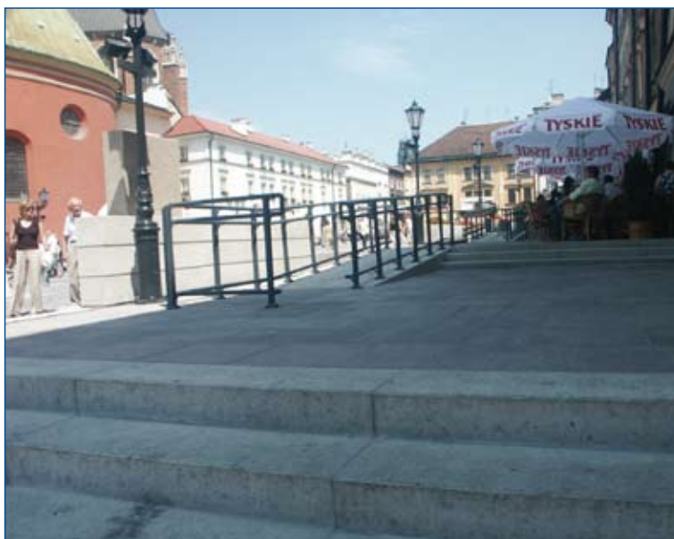
Fot. 3. Modernizacja Małego Rynku w Krakowie. Pochylnie prowadzą bezpośrednio na schody od ulicy Siennej (zdj. M. Wysocki).
